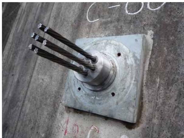
写真 5.2 防錆油の除去（例）
