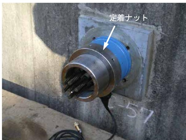
写真 5.7 定着ナットの取付け（例）
