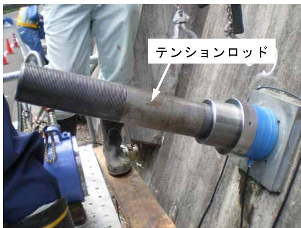
写真 5.8 テンションロッドの取付け（例）
