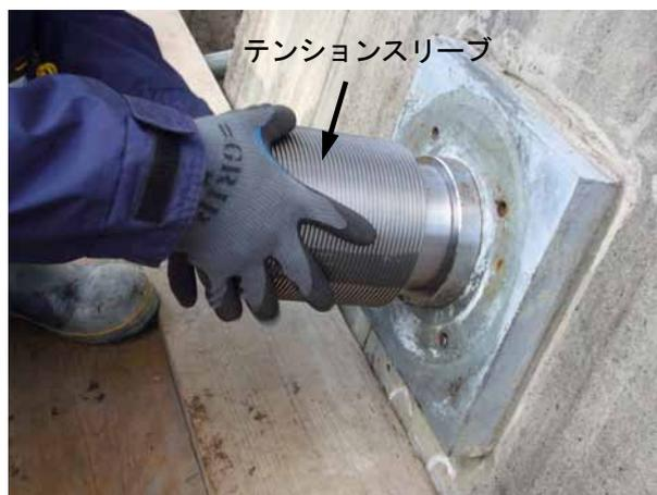
写真 5.5 テンションスリーブの取付け（例）
