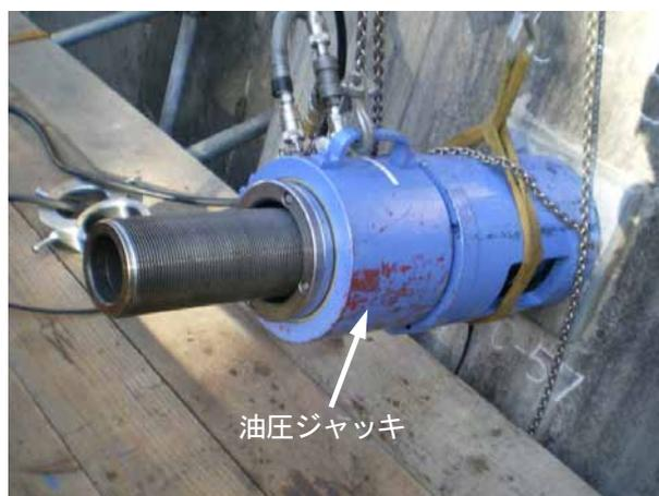
写真 5.10 油圧ジャッキの取付け（例）
