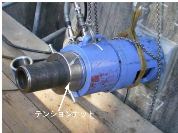
写真 5.11 テンションナットの取付け（例）
