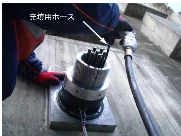
写真 5.14 防錆油の充填状況（例）
