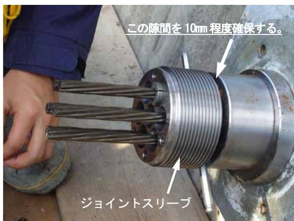
写真 5.3 ジョイントスリーブの取付け（例）
