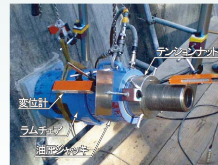
④ 緊張治具、変位計の取付け、リフトオフ試験の実施
