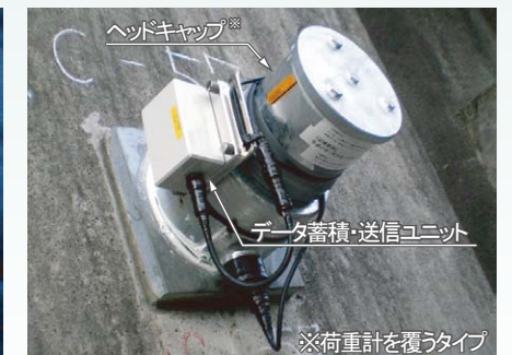
⑥ 緊張治具の取外し後、頭部防錆処理、データ蓄積・送信ユニットの取付け
