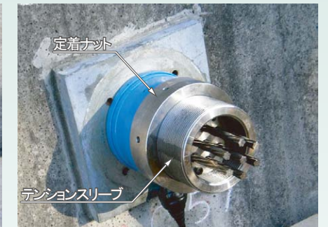
③ テンションスリーブ、定着ナットの取付け
