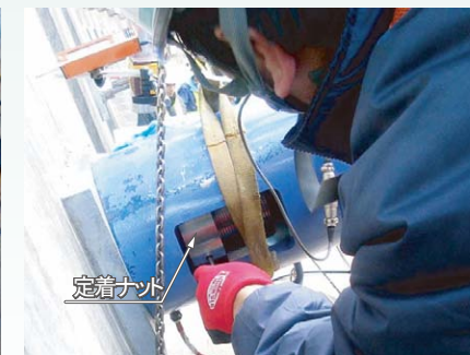
⑤ 定着ナットの締付け、荷重計定着
