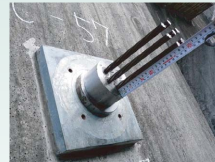
① ヘッドキャップの取外し、防錆油の清掃、再緊張余長の露出
