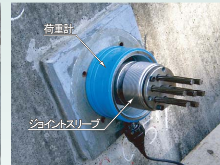
② ジョイントスリーブ、荷重計の取付け
